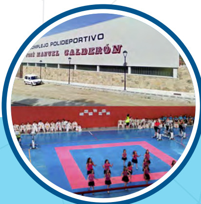
BAÑOS DE MONTEMAYOR Pabellón Municipal
